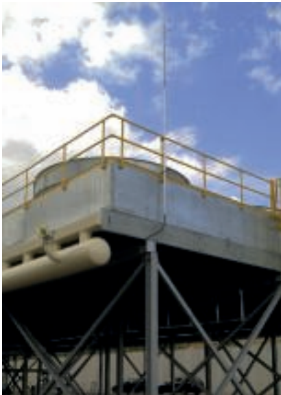
Impianto isolato su area con rischio di esplosione
