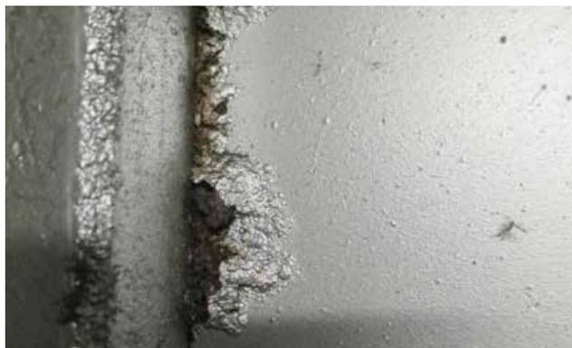
Corrosione interstiziale in un'armatura. A causa della formazione dalla ruggine sottostante, viene danneggiato il rivestimento (fonte: OBO Bettermann)
